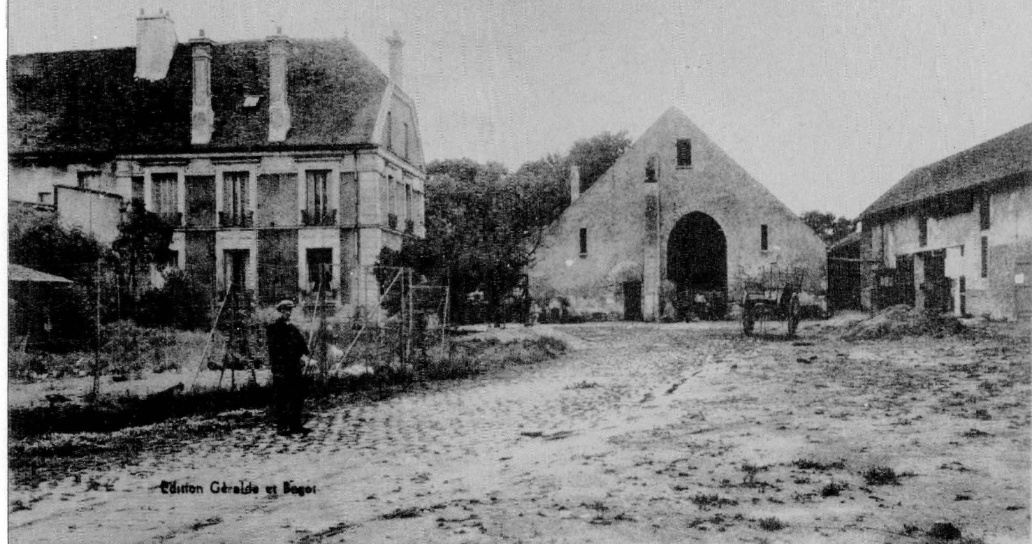
Wissous. – la grange aux Dîmes. (cliché Arch. dép. Essonne)
